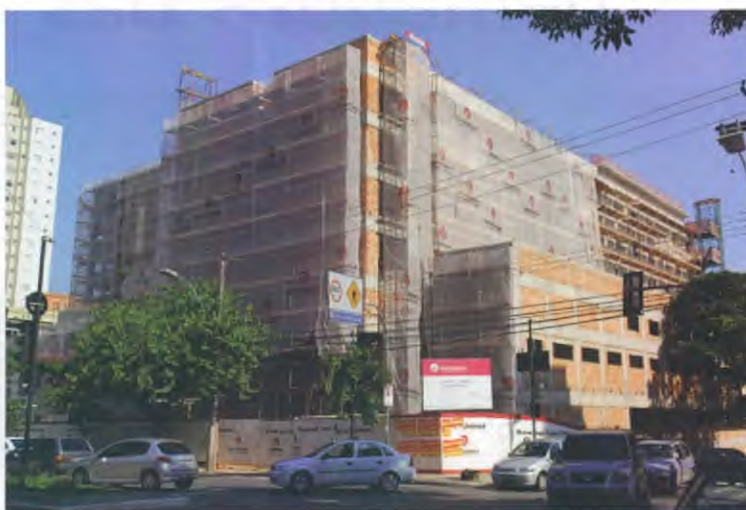
Obra do Hospital Unimed já está em fase de acabamento
